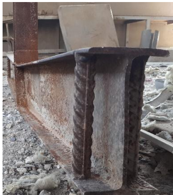
الشكل (٨) تقوية نهاية العضو الافقي بقضبان حديدية قطر 25 mm
