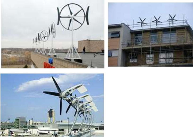
شكل (9) ادماج عدد من توربينات الرياح ذات المحاور الرأسية أو الأفقية صغيرة الحجم فوق أسطح المباني القائمة أو الحديثة[1].
